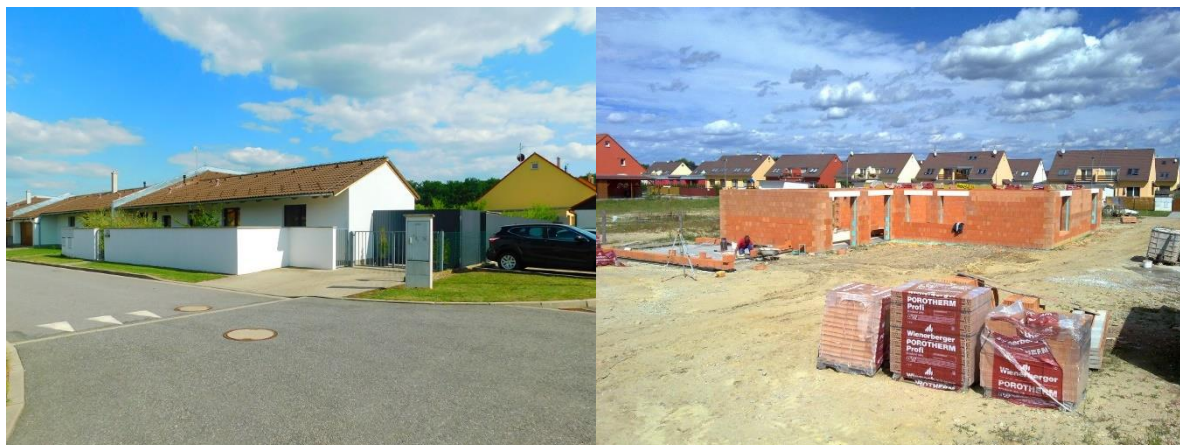
fotografie z výstavby bloku
